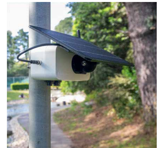
Installierte Sensoren für Messungen
