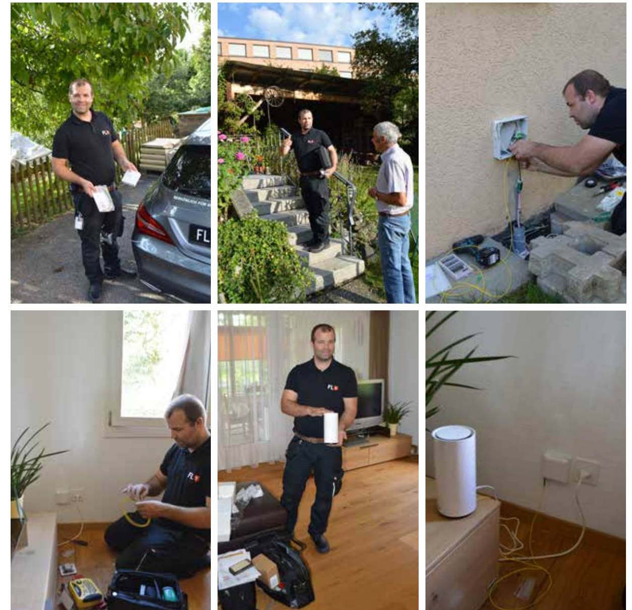
Installation eines Glasfaseranschlusses beim Kunden durch Rafael Sommerhalder | Field Force Engineer
